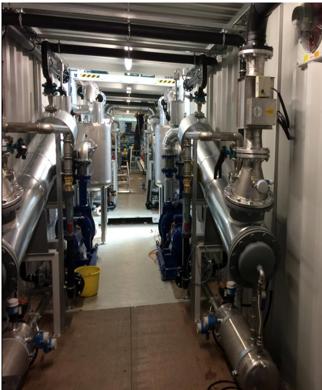
Anlagen zur Gaskühlung und Kondensation
