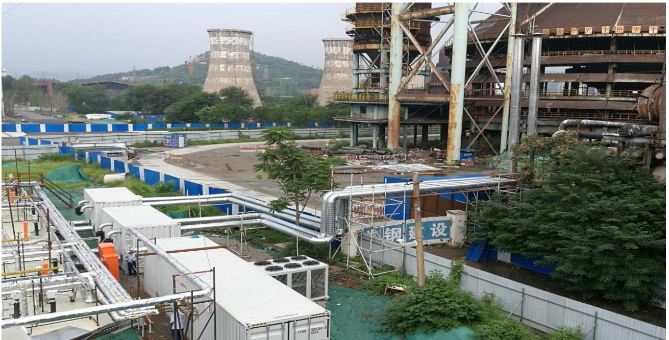
Oberflächenabsaugung und Abgasabführung
