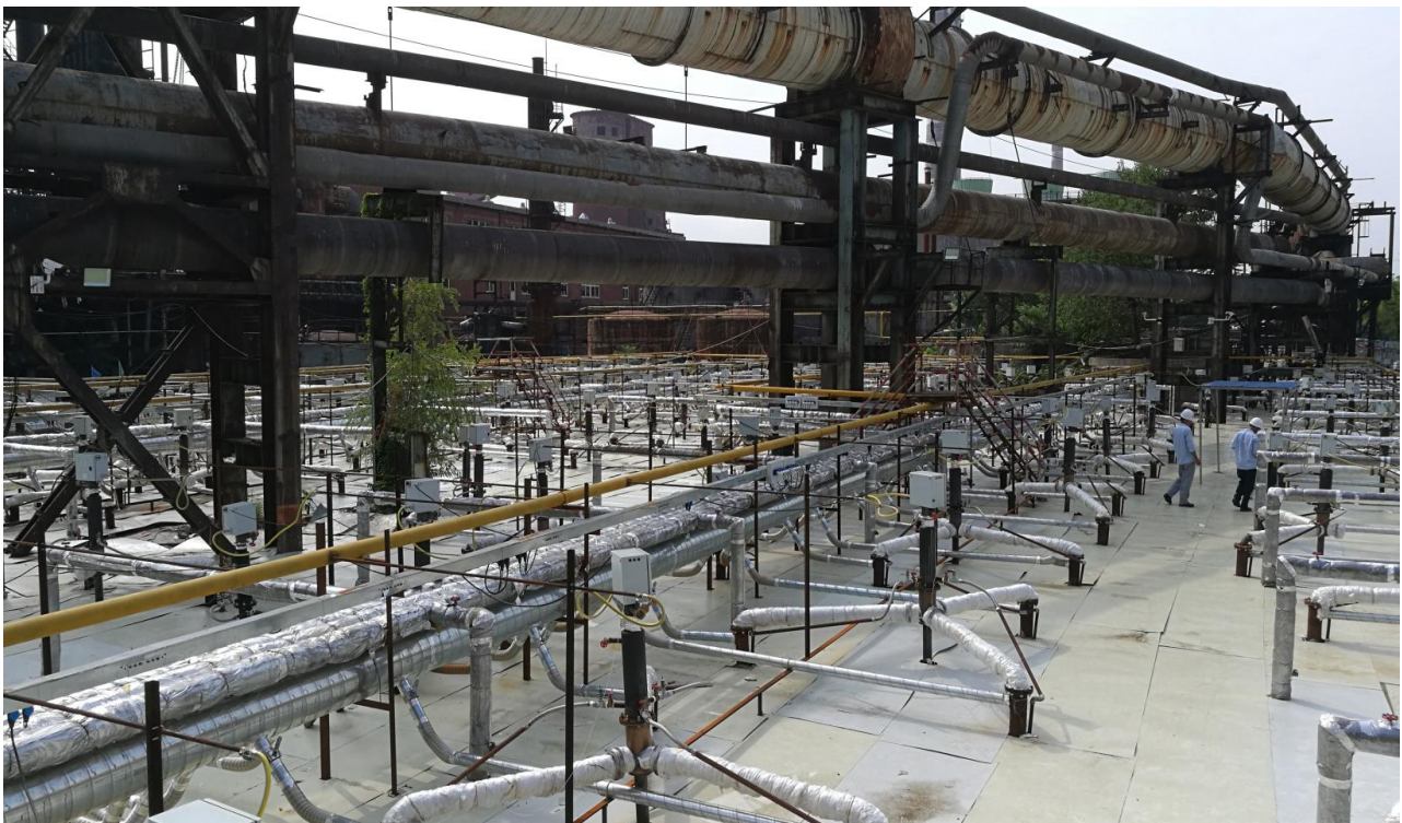
Teil eines Sanierungsfeldes bestückt mit Heizpegeln und Gasbrennern
