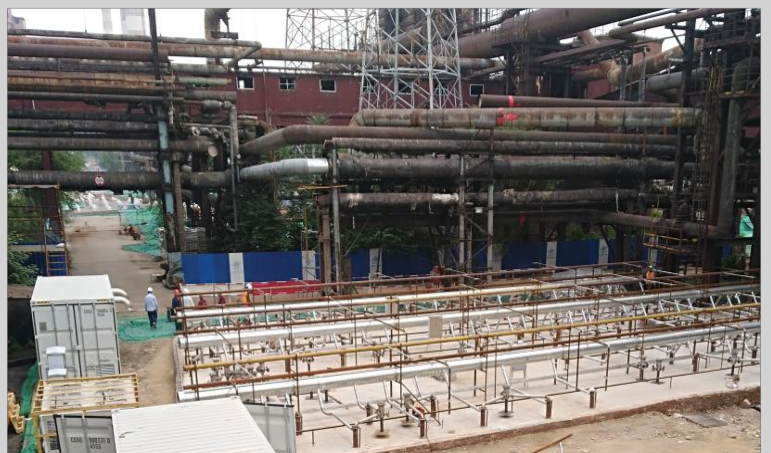
Abb. 4: Installation auf einer Teilfläche der Gesamtsanierung
