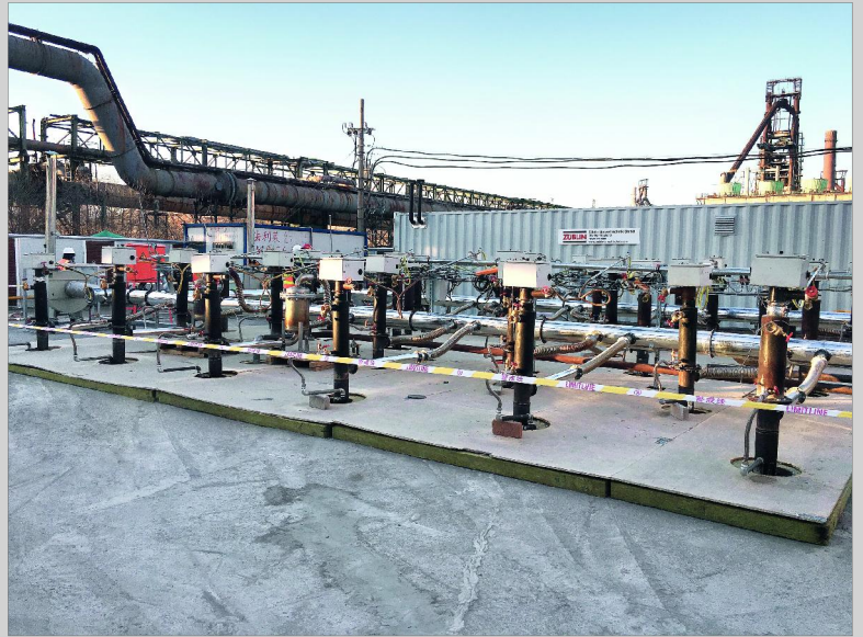
Abb. 1: ISTH-Verfahren mit gasbefeuerten Heizlanzen, Pilotversuch
