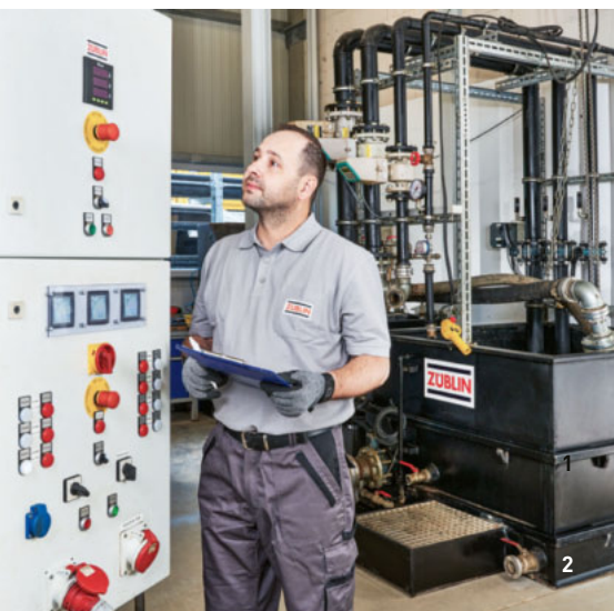
1 Site de Markgröningen/ 2 Atelier de réparation des pompes/ 3 Réalisation en 3 D d'une installation de traitement des eaux de construction/ 4 Installation de traitement des eaux de construction, échangeur de Wendlingen
