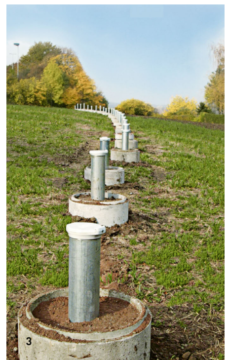
1 ISBO-Container, Italien/ 2 ISBO-Container/ Vertikaler Bodenfilter, Sachsen/ 3 GW-Messstellen zur \text{O}_2 -Versorgung, Bayern
