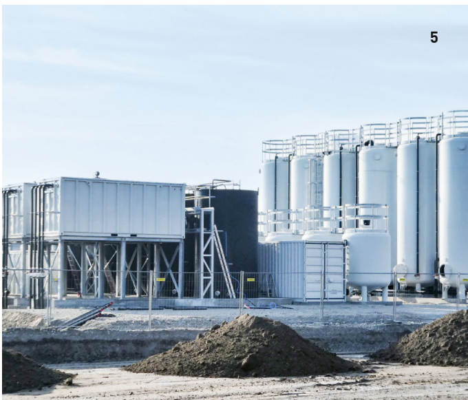
5 Absetzbecken, Kies und Aktivkohlefilter, IN-Campus Ingolstadt/ 6 Wasserreinigungsanlage Bodenwäsche, IN-Campus Ingolstadt/ 7 Wasserhaltung für bis zu 540 m³/h
