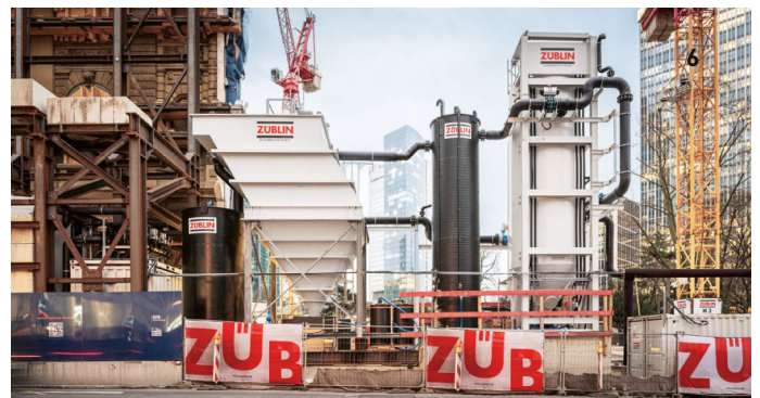
1 Bauwasserreinigungsanlage US-Klinikum Weilerbach/ 2 Bauwasserreinigungsanlage für Kreislaufwasserführung HDW, Stuttgart/ 3 Tunnelwasserreinigungsanlage, Katzenbergtunnel/ 4 Schlammabklärungsanlage HDW Schleusensanierung, Anderten Hannover/ 5 Tunnelwasserreinigungsanlage, Tunnel Rastatt/ 6 Bauwasserreinigung Central Business Tower Veritas Frankfurt
