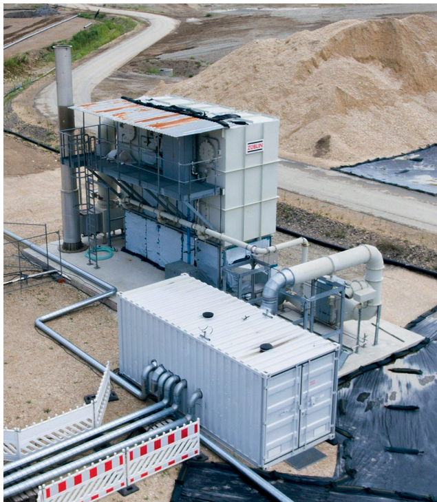
Abbildung 4: Abluftreinigungsanlagen für das Air-Sparging: Rekuperative Verbrennung (linkes Bild), Hochttemperaturfackel (rechtes Bild, linke Seite) sowie katalytische Nachverbrennung (rechtes Bild, mittlerer Anlagencontainer).
