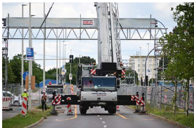
Abb. 10: Rohrbrücken zur Querung des Stadtringes
