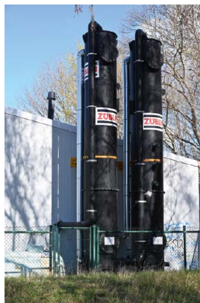
Abb. 7: Grundwasserreinigungsanlage zur Abstromsicherung, Fällung-Flockung-Sedimentation zur Abtrennung von Störstoffen (links); Strippanlage mit Abluftbehandlung, katalytische Nachverbrennung (rechts)
