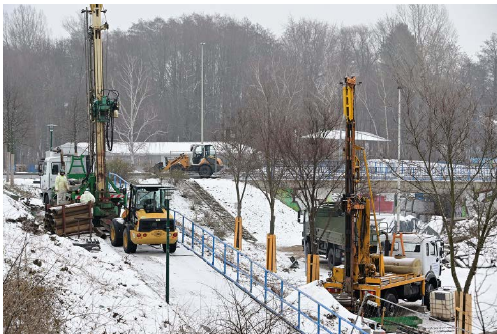
Abb. 8: Bohrarbeiten auf dem Parkplatz und Radweg im Bereich des Westschadens
