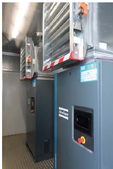
Abb. 11: Airsparginganlage mit Doppelkompressorenstation zur Druckluftversorgung (links), Druckluftverteilung (rechts); Ansteuerung der Druckluftventile (Mitte)
