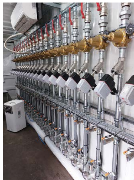
Abb. 11: Airsparginganlage mit Doppelkompressorenstation zur Druckluftversorgung (links), Druckluftverteilung (rechts); Ansteuerung der Druckluftventile (Mitte)
