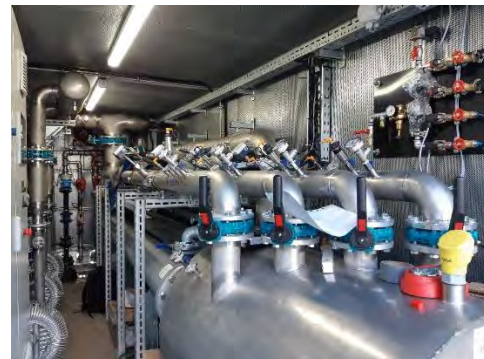
Abb. 9: Rohluftmesstrecken und Kondensatabscheider der Bodenluftabsauganlage
