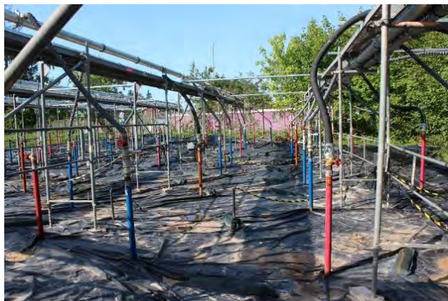
Abb. 5: Erschließung Sanierungsfläche (rot = Injektionsbrunnen, blau = Absaugbrunnen)
