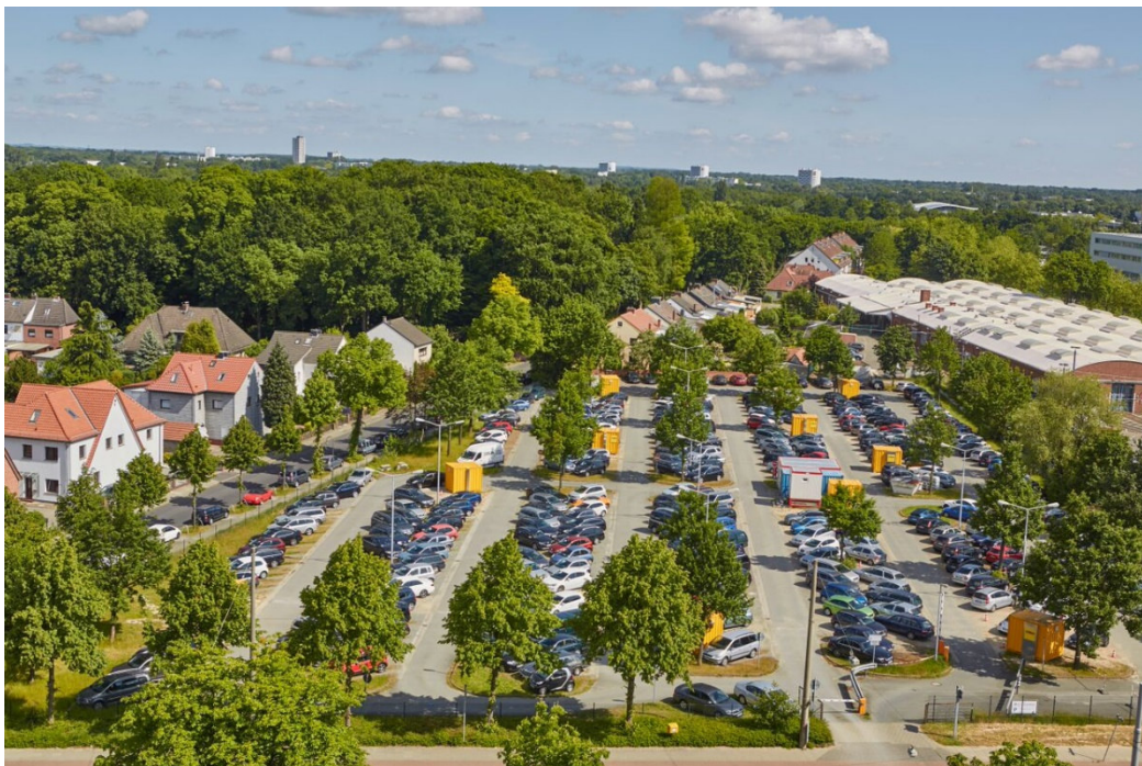
Abb. 5: Kombinierte ISCO/ISBR-Sanierung am Standort Bremen
