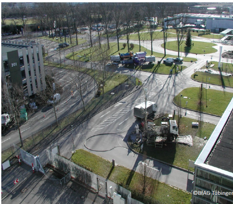
Abb. 4: Bohrarbeiten für die erste großtechnisch durchgeführte ISCO-Sanierung in Deutschland an einem Produktionsstandort der Automobilindustrie in Baden-Württemberg
